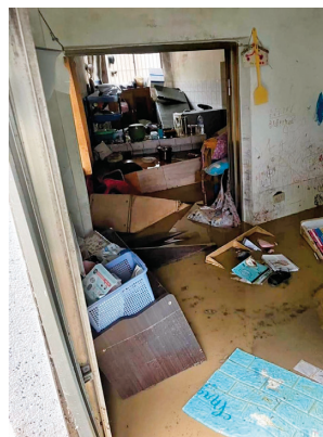
信徒房屋毀損情況
