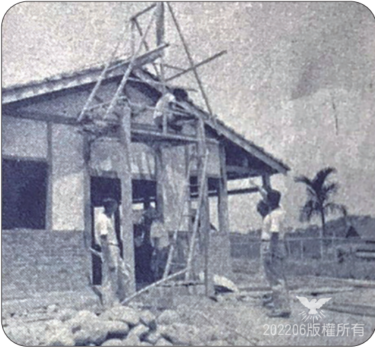
▲ 施工中監造，左起：劉家發、木匠、蔡廷輝、蔡守道。
